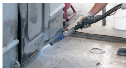
Fig. 11 Sandblasting
