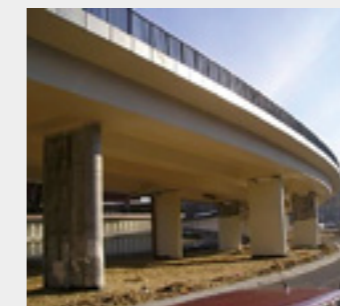
The Galicyjska Bridge, Krakow (PO)
