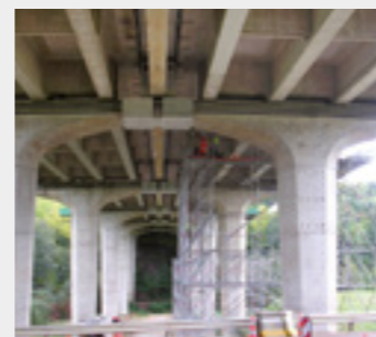
Toutry Bridge, (FR)
